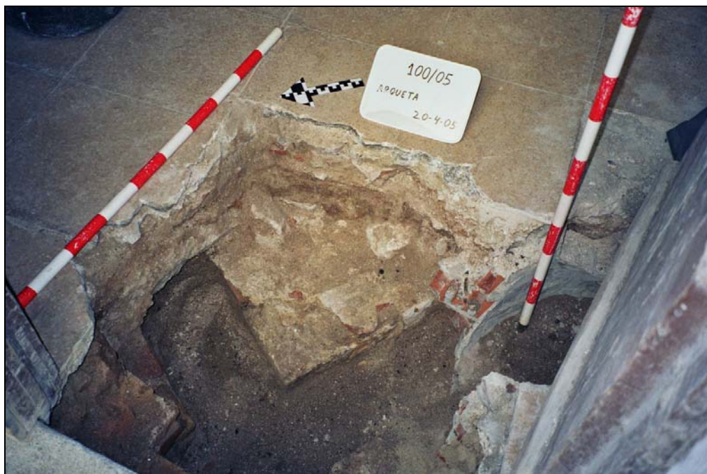
Figura 2. Arqueta escomesa d'aigües. Desguàs i arqueta anterior.
